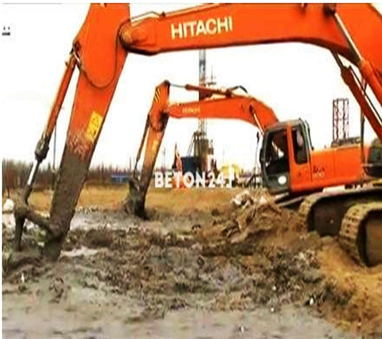
Рисунок 3.1 - Техника перемешивания грунта экскаватором
